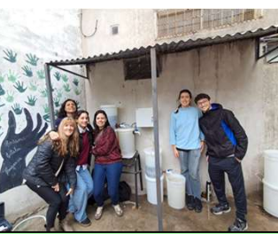
Instalación de Planta Piloto en Escuela Secundaria N°47, Barrio Carcova.
